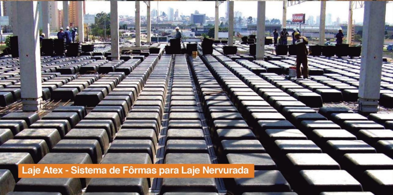
Laje Atex - Sistema de Fôrmas para Laje Nervurada
