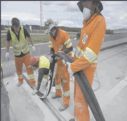
Perfil UT 50 LPE Confort Instalado
